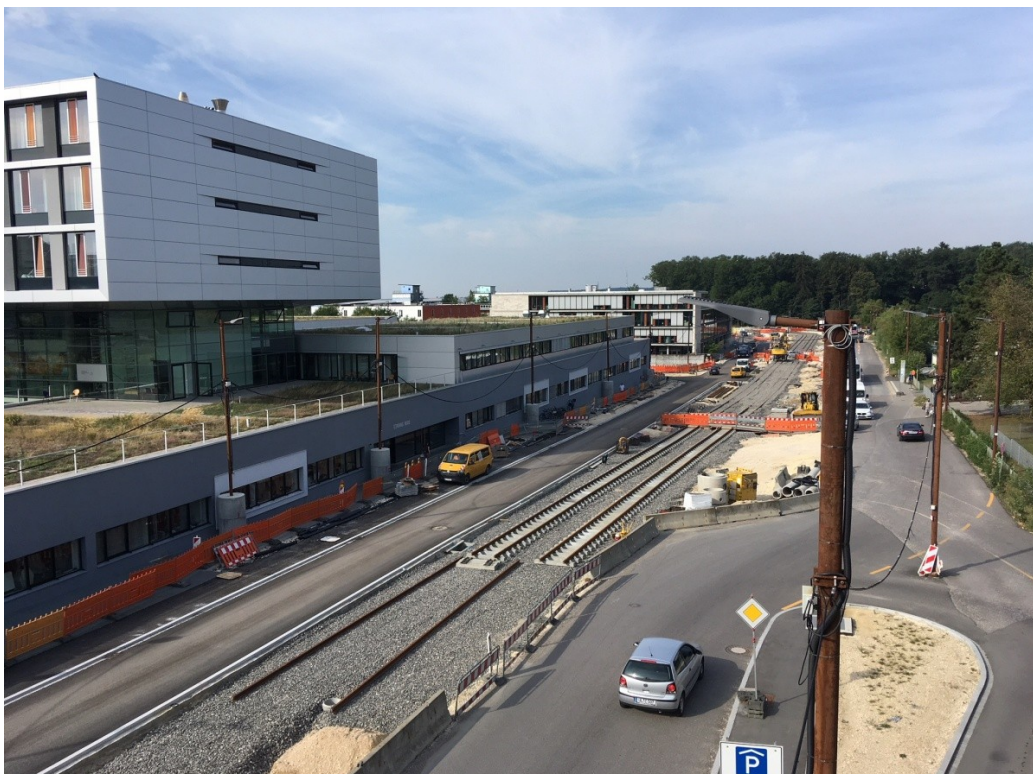
Blick vom Parkhaus auf die neue Straßenbahntrasse beim Klinikum im Jahr 2018
