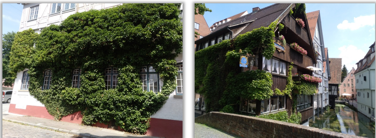
Abb. 28: Ausführungsbeispiele für Fassadenbegrünung in der Ulmer Innenstadt
