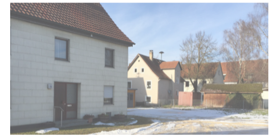
Bestand Kirchberger Straße 5, Blick Richtung ehemaliges Rathaus
