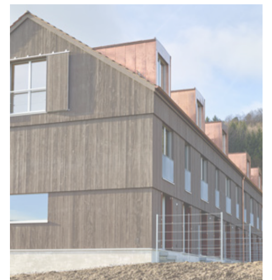
Referenzprojekt 1: Reihenhaus, Hinteregg, Wirz Architekten
