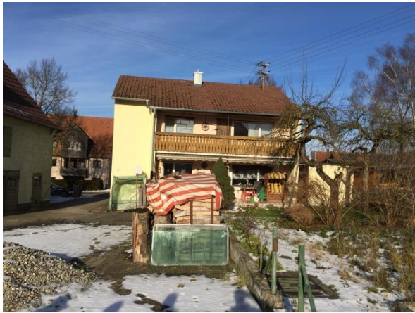
Kirchberger Straße 3 Quelle: die STEG
