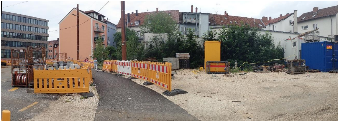
Nordrand des Plangebietes: keine Gehölzstrukturen mehr am Nordrand Richtung Karlstraße (= Baustelle Straßenbahn); Richtung Osten (Blickrichtung) schmaler Rest-Gehölzstreifen (junge Birken, Berg-Ahorn, Salweide, Clematis, Efeu etc.); keine Vogel-nester oder Baumhöhlen
