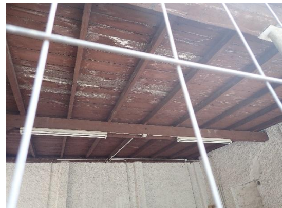
Detail Carport/Schuppen: keine Vogelneester; kein zugluftsicherer Unterschlupf für Fledermäuse
