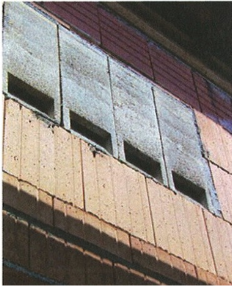
Abb. 4 Fledermauskästen als Einbausteine für Fassaden in einem Rohbau
