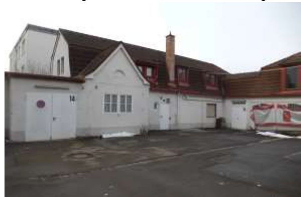
Gebäude 10 von Osten aus.
