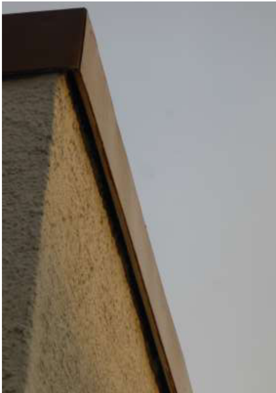
Dachkantenabschluss von Gebäude 9, Blech, glatt, innen abgedichtet.
