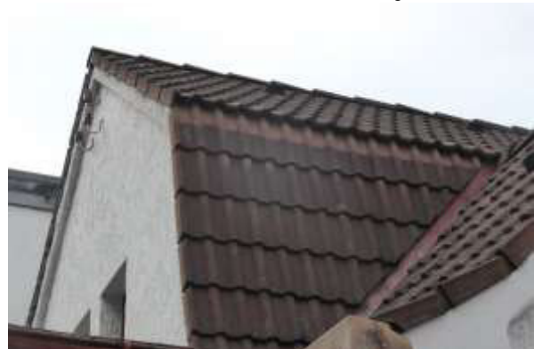
Gebäude 10, Dach, Südseite.
