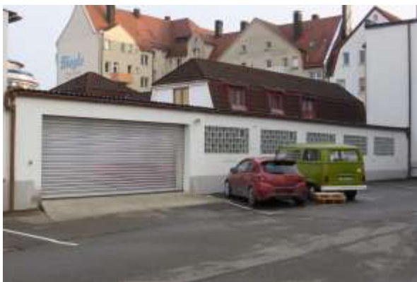
Gebäude 14 von Westen.
