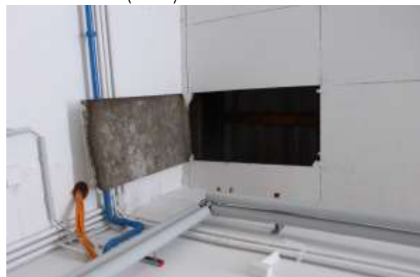
Gebäude 13, abgehängte Decke von innen.
