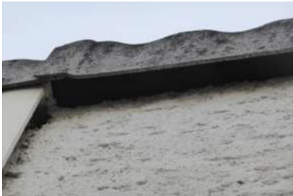
... mit Fuge an Dachkante und rauem Putz.
