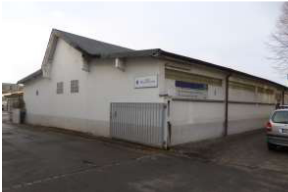
Gebäude 1, von Südosten
