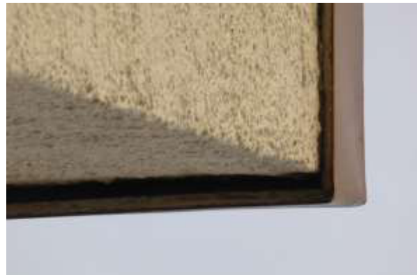
Dachüberstand mit Spalte, aber abgedichtet.
