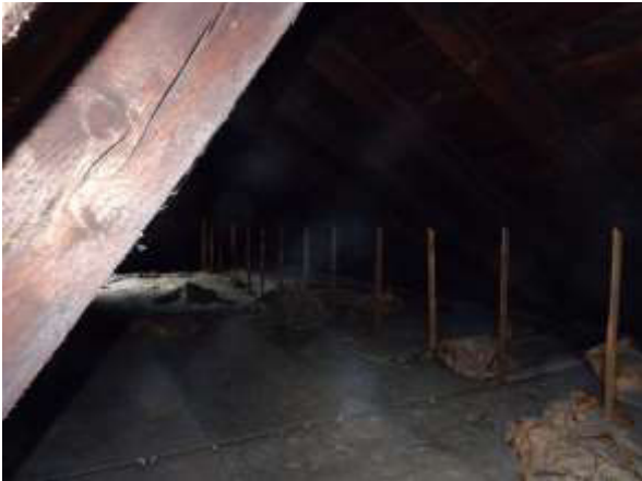
Dachboden Nordteil, Nordseite
