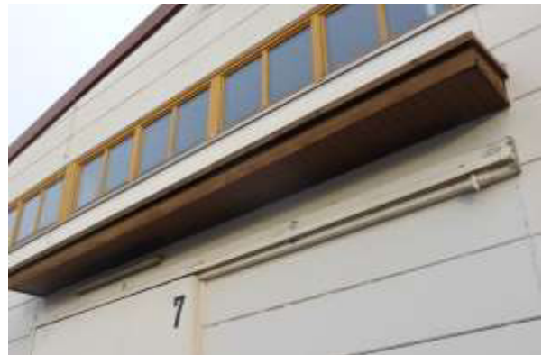
Dachüberstand auf Westseite, holzverkleidet ...
