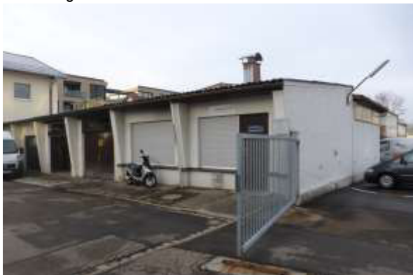
Gebäude 7 (die beiden Segmente rechts).
