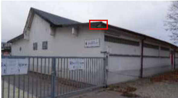
Gebäude Magirusstr. 28 von Südosten, von der Straße aus. Ausschnittvergrößerung s.u.
