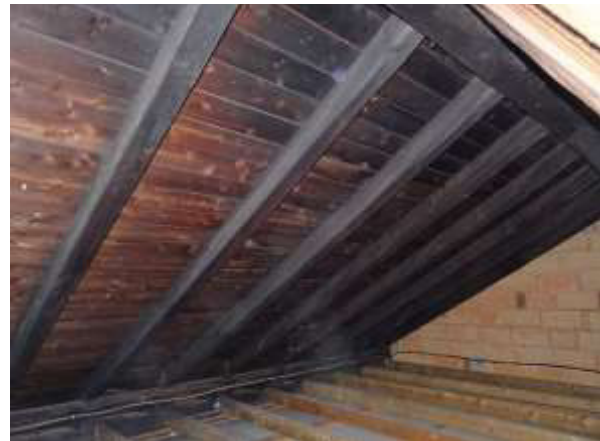
Dachboden Südteil, Südseite.
