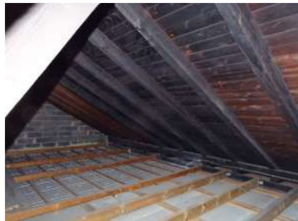
Dachboden Südteil, Nordseite.
