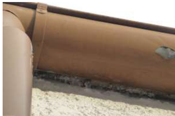
Dto., Dachrinne liegt fugenlos an Hauswand an.
