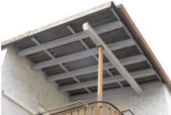
Dachüberstand an der Südostecke von Gebäude 5.
