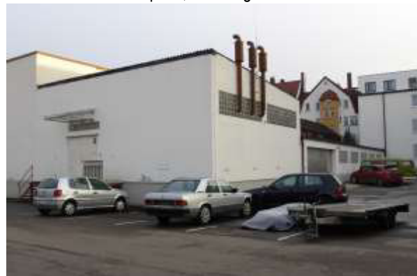
Gebäude 13 und (rechts) 14 von Nordwesten.
