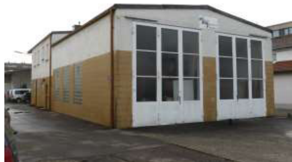
Gebäude 4 und 5 (hinten) von Nordosten ...
