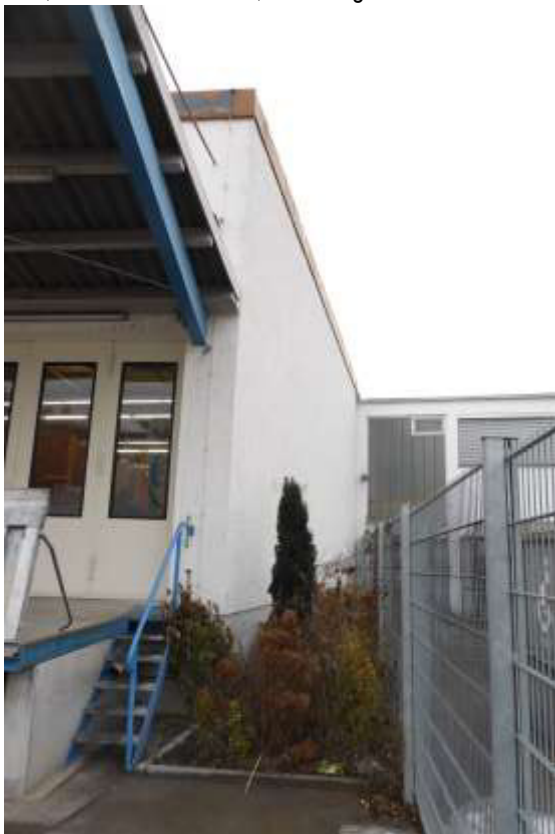
Gebäude 3a, Nordostecke.
