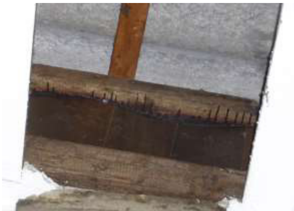
Dto. vergrößert, Blick durch die Öffnung auf die Dachunterseite.
