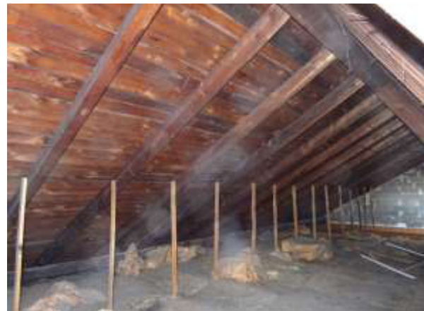
Dachboden Nordteil, Südseite.
