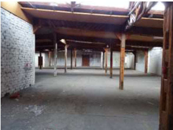
Dto. von innen; hell, Dach dicht, abgehängte Isolierung.
