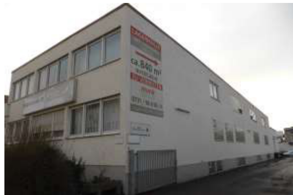
Gebäude 12, Ost- und Nordseite.
