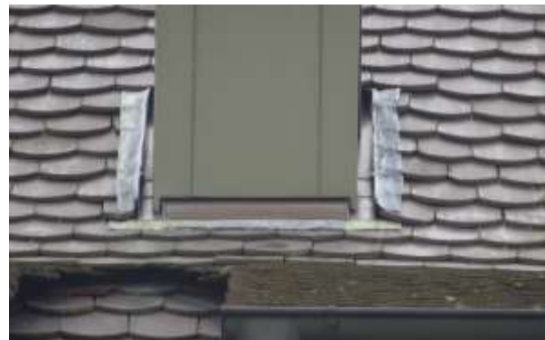
Kamin-Verblendung mit Blech.
