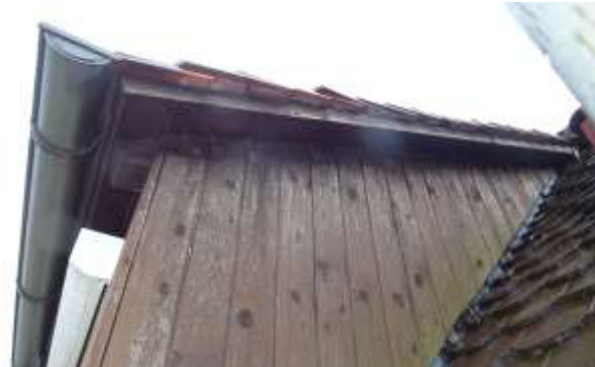
Auch die Holz-Verkleidung nach oben ist fast fugenlos, wenn Fugen vorhanden sind, dann nur wenige mm breit.
