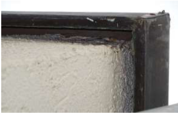
Dachüberstand der Garagen: Offen, z.T. mit Spinnweben; keine Spaltenquartiere.
