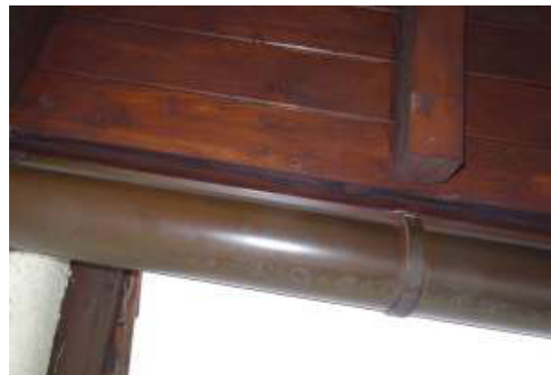
Dachüberstand Hinterseite, von unten, Struktur wie vorher.
