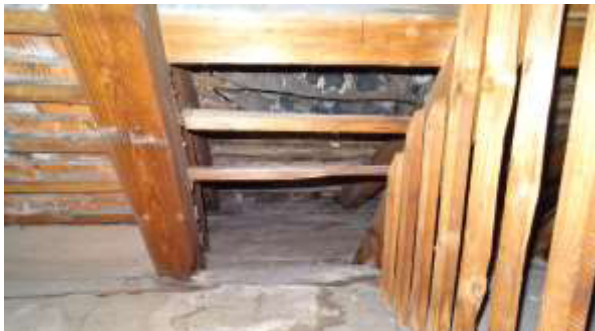
Oberer Ansatz einer hinteren Dachgaube mit Dachpappe.
