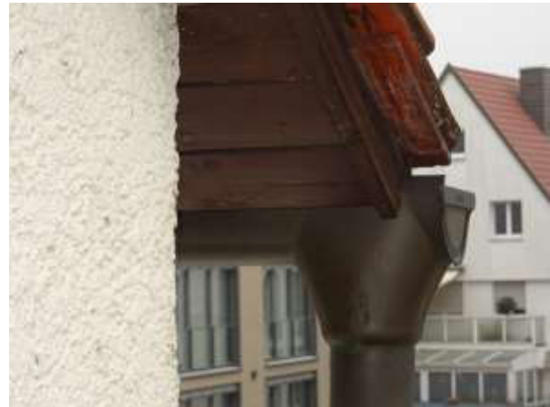
Ecke des Anbaus hinten. Alle Bretter dicht, gestrichen.
