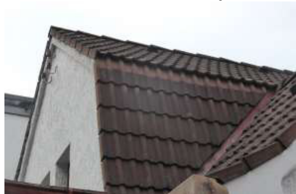
Gebäude 10, Dach, Südseite.
