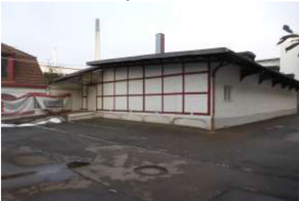
Gebäude 11 von Südwesten, links noch Gebäude 10.
