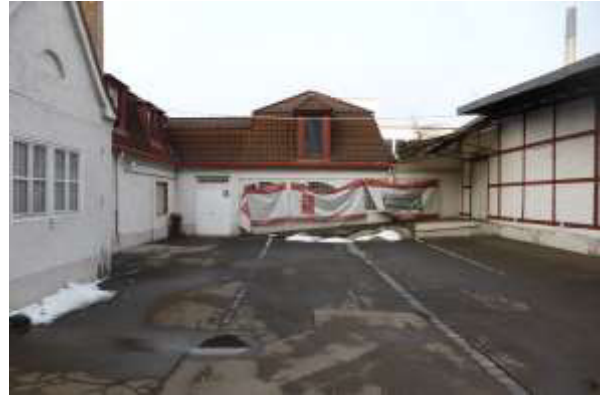
Teil von Gebäude 10 mit innen offenem, ausgebautem Dach.
