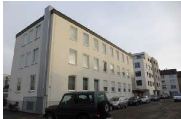
Gebäude 8; rechts Neubau Gebäude 15.
