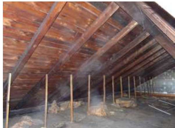
Dachboden Nordteil, Südseite.
