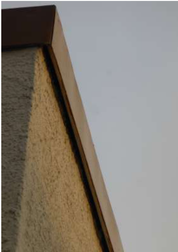
Dachkantenabschluss von Gebäude 9, Blech, glatt, innen abgedichtet.
