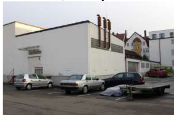
Gebäude 13 und (rechts) 14 von Nordwesten.
