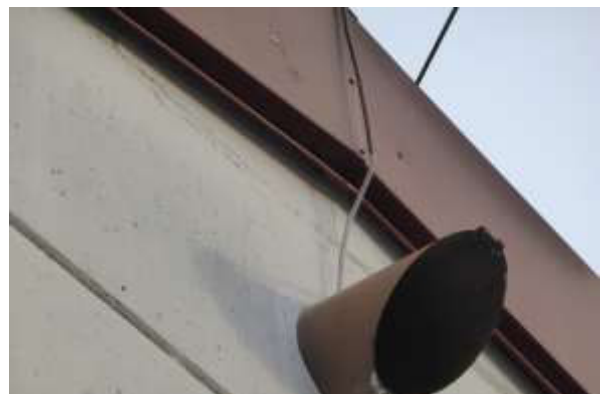
Dachkante verblecht, dicht anliegend, keine Spalte
