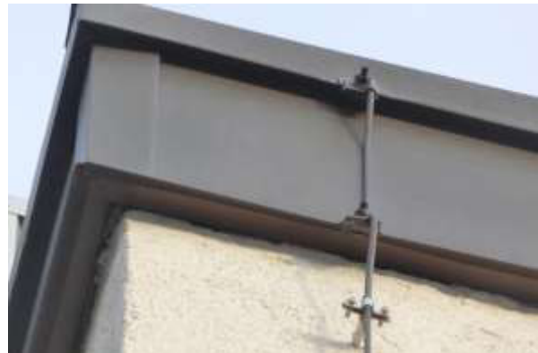
Dachabschluss von Gebäude 8: sauber verblecht.
