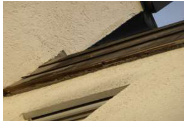
Wieder dicht abgeschlossene Dachkantenverkleidung.
