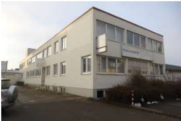
Gebäude 12, Süd- und Ostseite.
