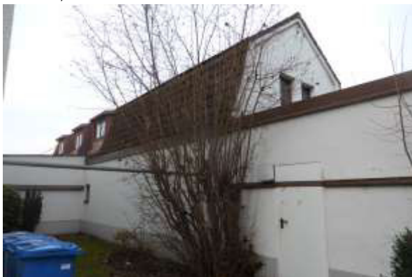
Gebäude 10, von der Südostecke des Gebäudes 9 aus.
