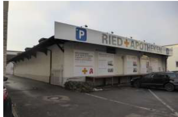
Ostseite von Gebäude 11 ...
