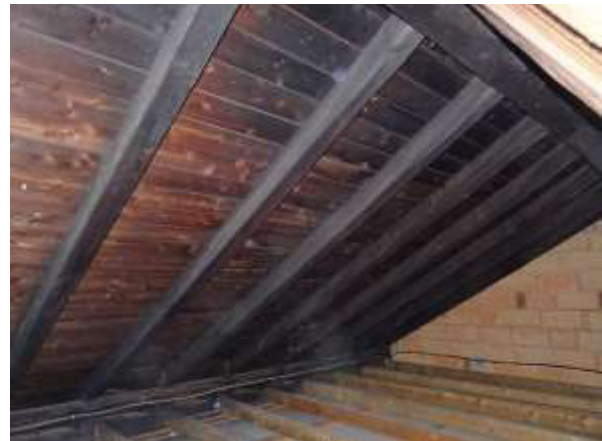
Dachboden Südteil, Südseite.
