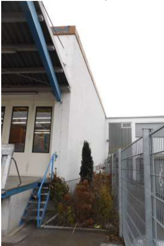
Gebäude 3a, Nordostecke.
