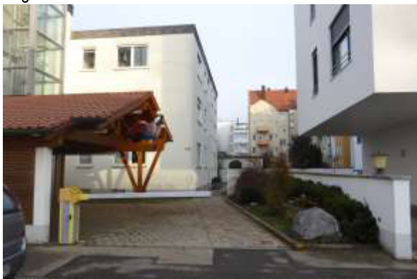
Carport am Süde von Gebäude 8, im Hintergrund Gebäude 9, rechts minimaler Grünstreifen.
