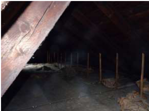
Dachboden Nordteil, Nordseite
