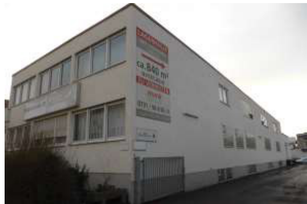
Gebäude 12, Ost- und Nordseite.
