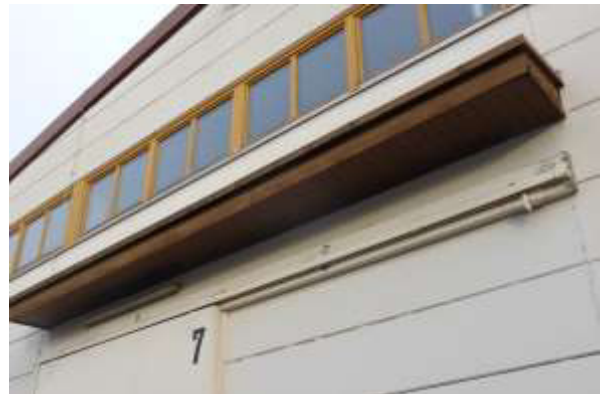
Dachüberstand auf Westseite, holzverkleidet ...
