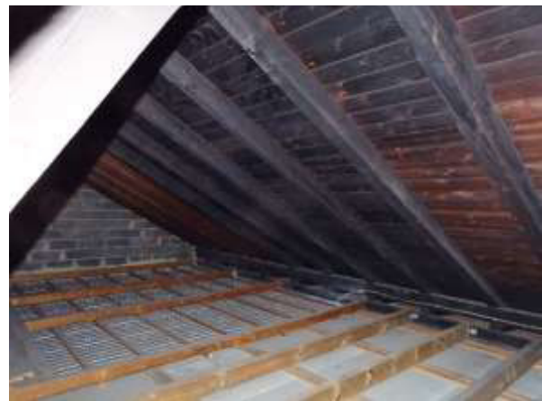
Dachboden Südteil, Nordseite.
