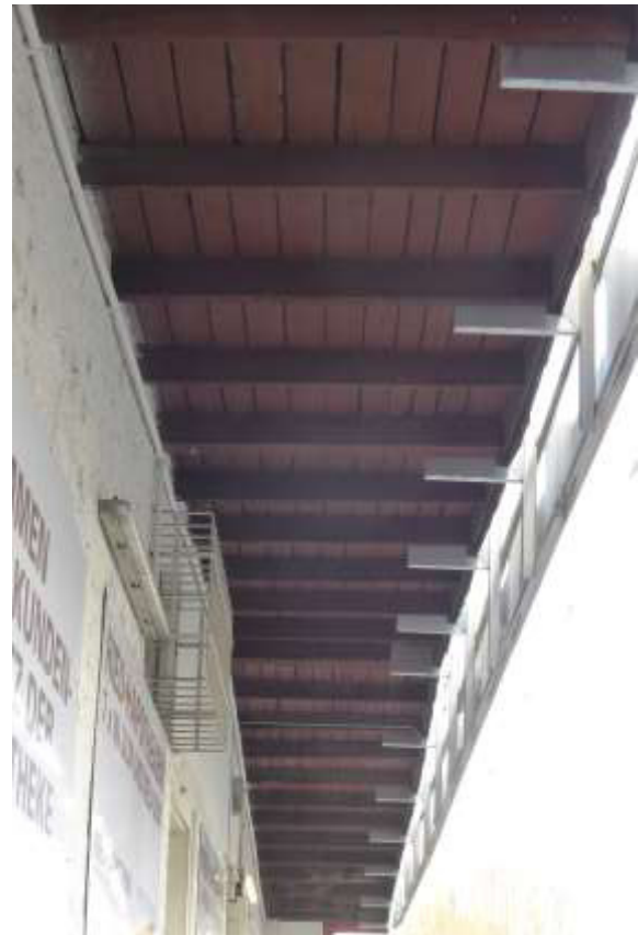
... mit geschlossenem Dachüberstand.
