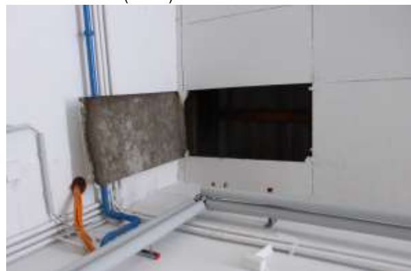
Gebäude 13, abgehängte Decke von innen.
