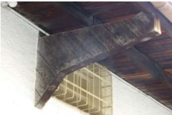
Dachüberstand auf der Südseite von Gebäude 11 mit offenen, verkleideten Balken.
