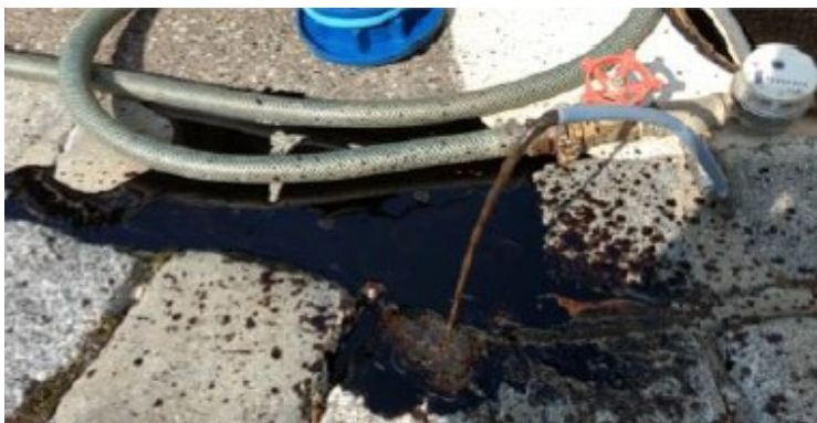
Abb. 4: Grundwasser im Schadenszentrum
