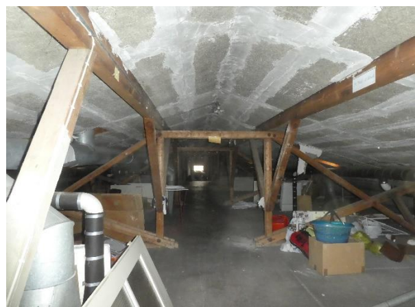
Dachboden des Nordteils von innen, kein Kot, keine Öffnungen.
