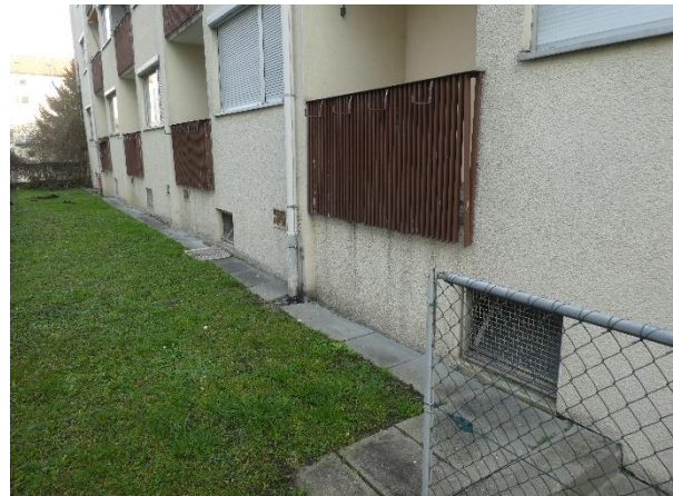
Westseite, untere Etagen. Die Balkon-Holzverkleidungen sind offen und bieten keine Spalten oder Lücken.
