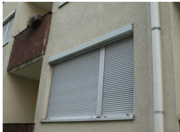
Beispiel für Blech-Jalousienkästen, für Vögel oder Fledermäuse ungeeignet.
