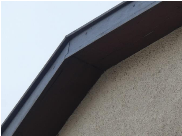
Dachüberstand auf der Westseite, dicht.
