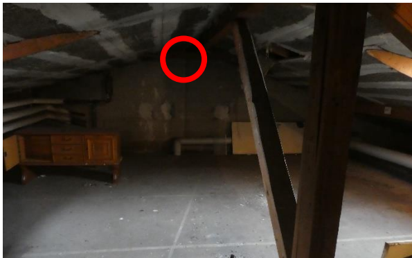
Südteil, Südgiebel-Innenwand mit Fledermaus-Hangplatz im Dachspitz (Kreis), ...
