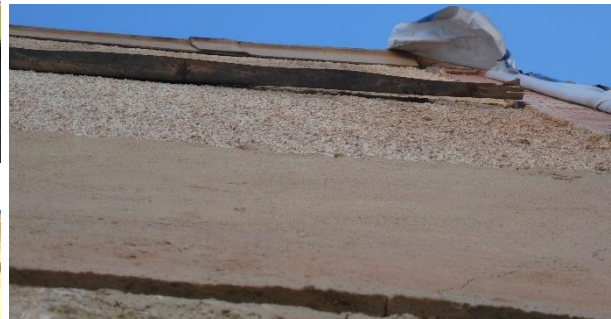
Auch diese Spalten waren bis vor Kurzem noch zugebaut; sie waren im Übrigen glatt (Metall) und leer.
