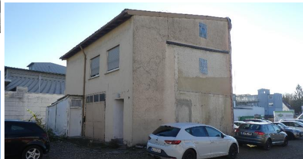
Gebäude, Blick von Nordwesten; man erkennt gut die Kontur des im Westen ehemals angebauten, jetzt abgebrochenen Gebäudes.
