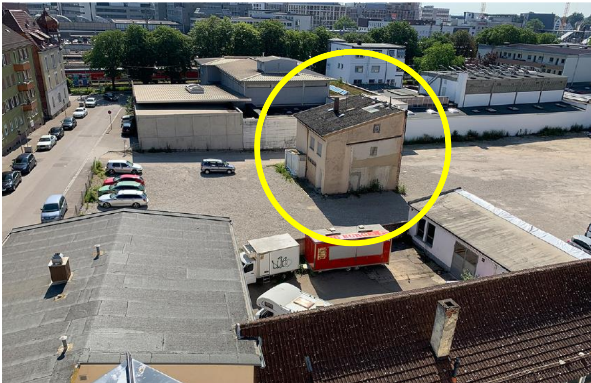
Abb. 2: Vom neu gebauten Gebäudekomplex im Westen ist das mittlerweile allein und frei stehende Haus Mörikestr. 9/1 gut zu erkennen.
