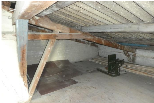
Dach, vor Kurzem noch genutzt, jetzt freigeräumt.
