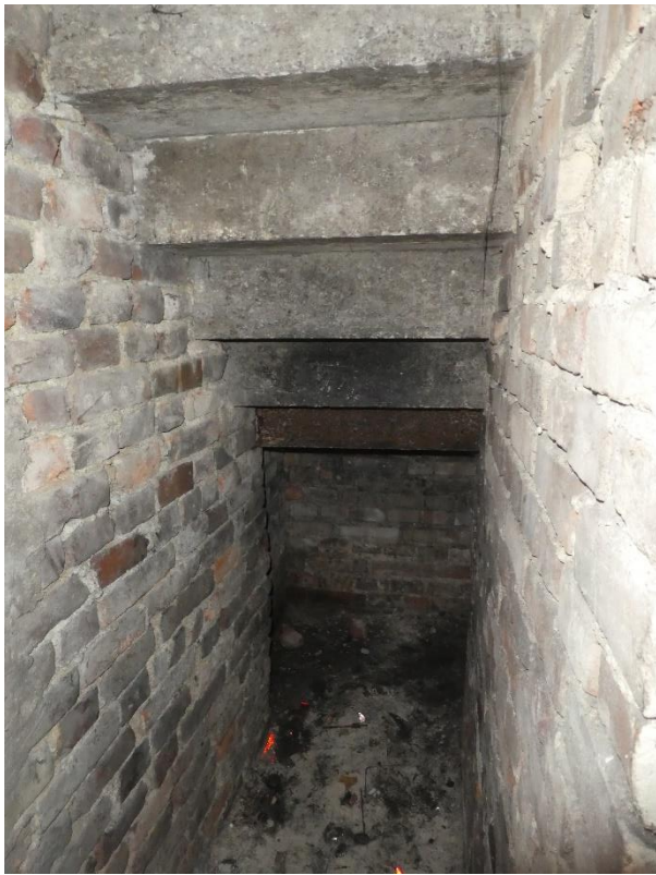
Fensterloser „Raum“ unter der Kellertreppe.
