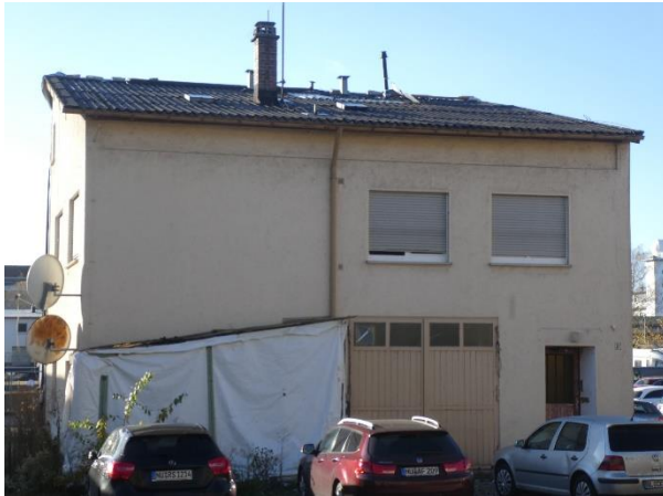
Gebäude, Blick von Norden. Der „Verschlag“ links unten ist der Eingang zu einer zweiten Wohnung (s. u.).
