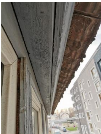
Abb. 3: Dachüberhang der Lagerhallen-Dachgaube.
