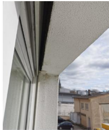
Abb. 2: Links: Das zu untersuchende Wohnhaus A (links) und Lagerhalle B (rechts) mit aufgesetzter Dachgaube. | Rechts: Spalt zwischen Fenster und Fassade im Wohngebäude.
