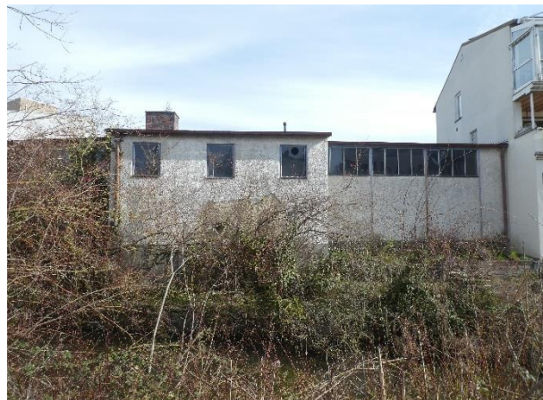
Östlichster Teil der Lagerhalle, Technik-Raum springt etwas vor.
