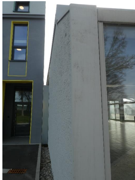
Nördliche Außenwand des Ausstellungsgebäudes, ...
