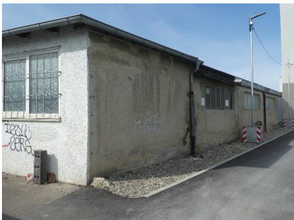
Nordostecke, Nordfassade desselben Gebäudes.
