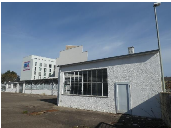
Die beiden Garagen an der Kleiststr. (Ostseite).
