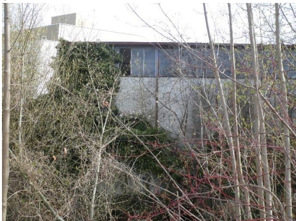
Dto., Südwestecke der Lagerhalle.
