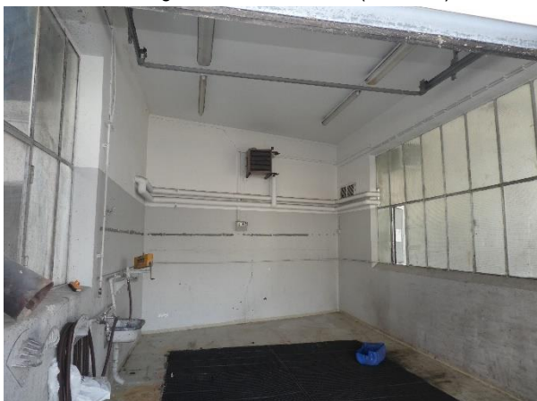
Eine der beiden Garagen von innen.
