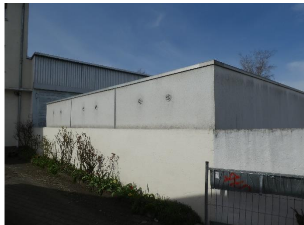
Nordost-Außenseite des Gebäudes Kleiststr. 15.
