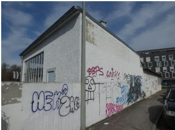
Nordost-Außenseite des Gebäudes Innere Wallstr. 38.
