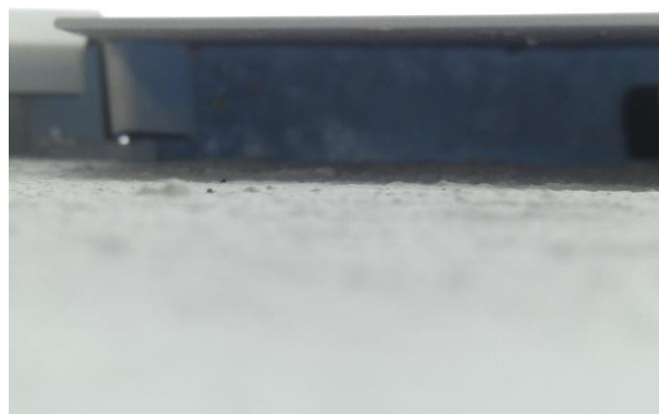
Blick von unten in die Fuge (leider unscharf).
