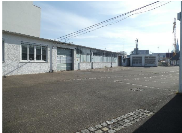
Werkstatthalle (Innere Wallstr. 38) und Garagen.
