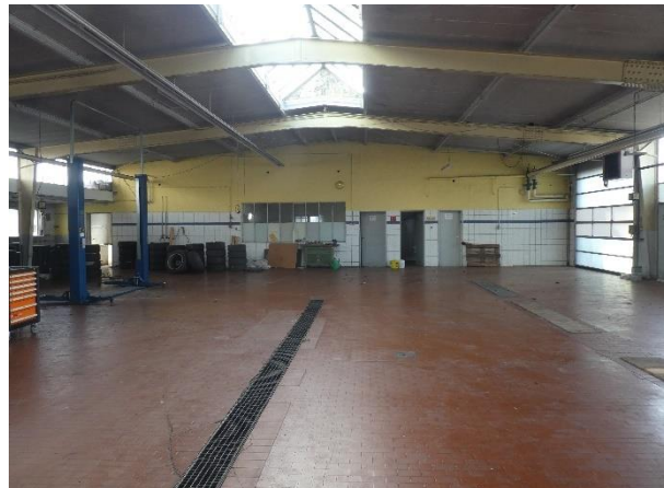
Werkstatthalle innen, Blick nach Osten ...
