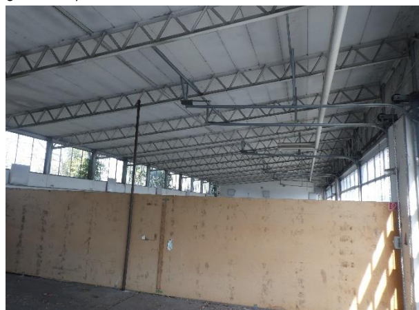
Lagerhalle Kleiststr. 15, innen abgeteilt.
