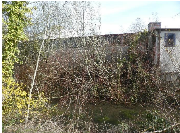
Dto., rechts Technik-Raum
