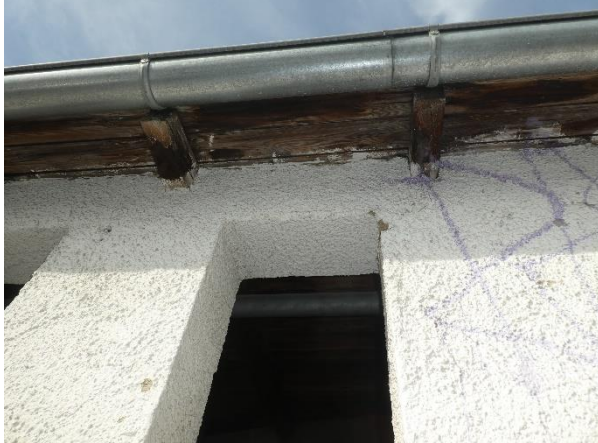
Eine der „Fenster“-Öffnungen des o. g. offenen „Raums“ in der Nordostecke des Grundstücks.
