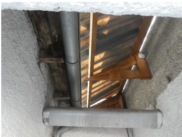
Dto. offenes Dachgebälk, keine Vogelnester o. ä. sichtbar (vermutlich weil zu oft genutzt = zu stark gestört).
