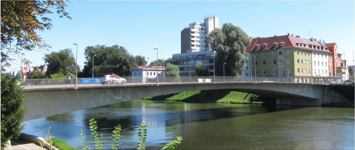
In der Entwurfsplanung des Ersatzneubaus der Gänstorbrücke werden Reminiszenzen an die Vorgängerbauten aufgenommen, um die Spuren der Geschichte nicht zu verwischen. Die Bastionswände der 1. Gänstorbrücke von 1912 werden erhalten/wiederaufgebaut und die prägnante und sehr schlanke Figur des Bauwerks durch den Einsatz neuer Materialien sowie Bau- und Planungstechniken erhalten und neu interpretiert. Der Finsterwalder Grundgedanke des eingespannten Rahmens wird adaptiert.
