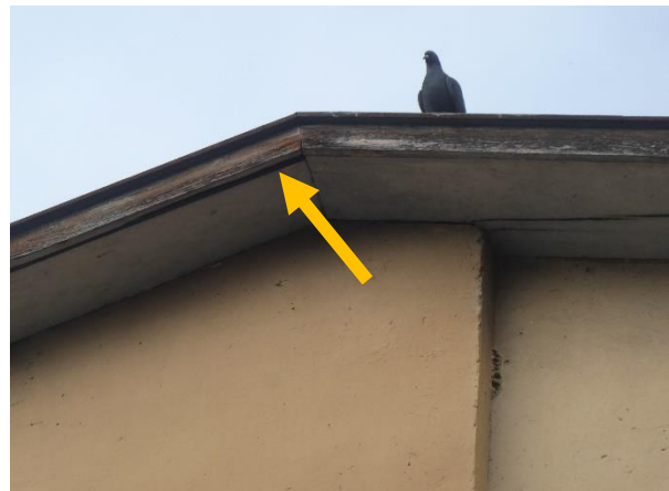
... hier einmal das abstehende Brett mit Spalte, in die vermutlich Fledermäuse einfliegen; zum Anderen ein potenzieller Dachbodenbewohner, wenn man nur ein Fenster öffnen würde ...
