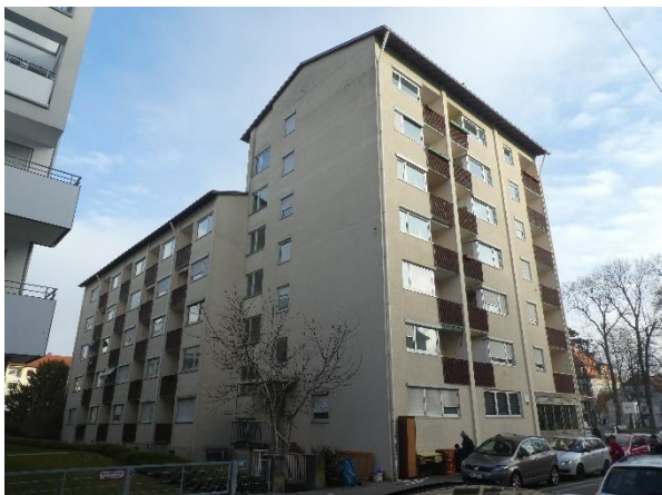
Blick von Südwesten
