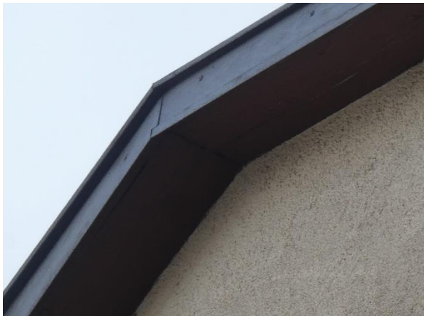
Dachüberstand auf der Westseite, dicht.
