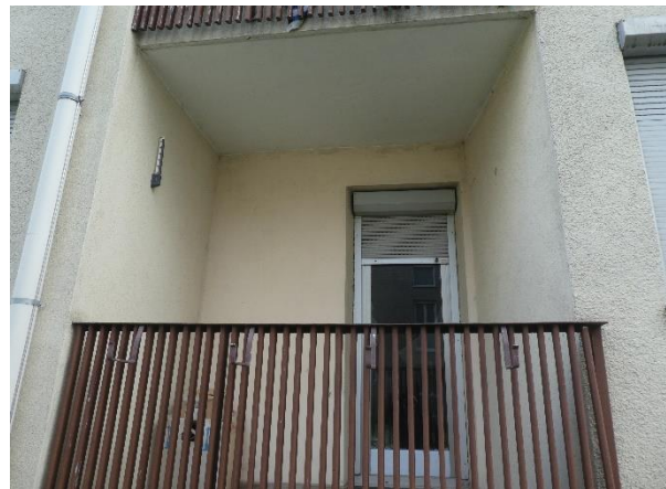
Beispiel für eingezogenen Balkon, dieser ebenfalls ohne Spalten o. ä.
