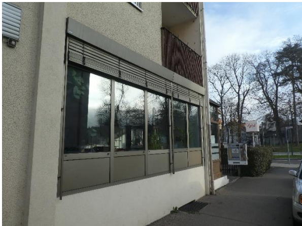
Fassade Gaststätte, wieder nur glattes Metall.
