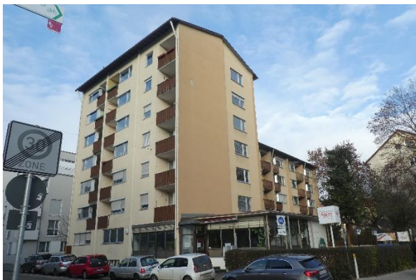
Blick von Südosten.
