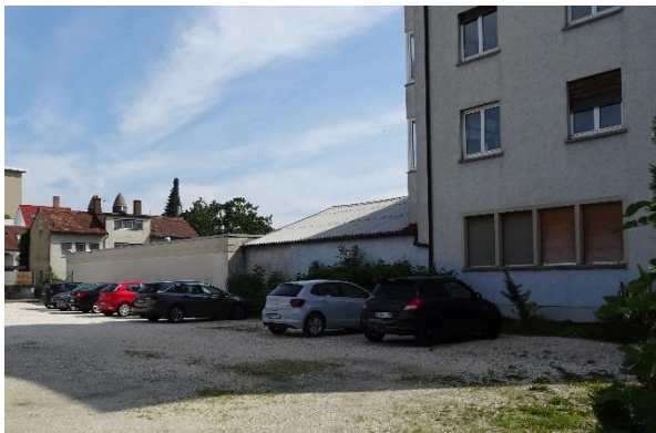
Mittel- und Rückgebäude von Südwesten.
