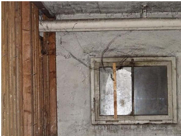
Kellerräume, Beispiel 2 (mit Spinnweben).
