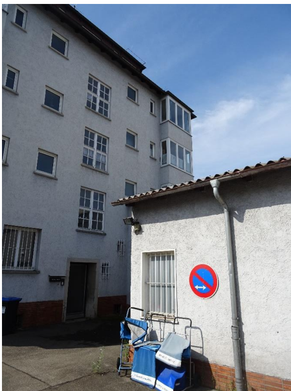
... und Westteil; rechts schon das Mittelgebäude.
