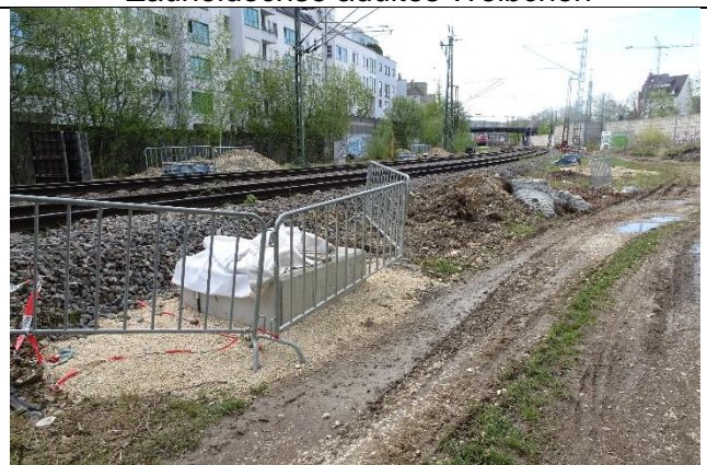
Baumaßnahmen entlang Bahn
