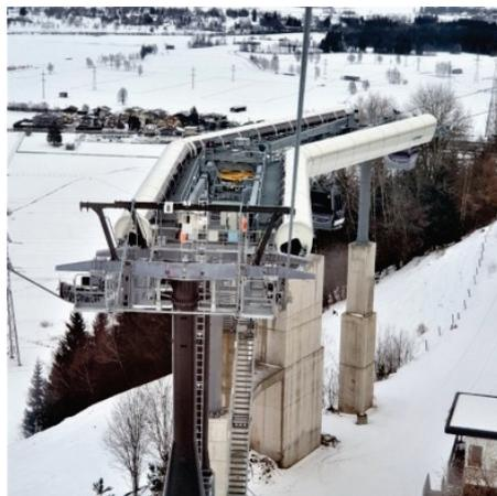
Abb. 11. Beispiel für eine Umlenkstation
