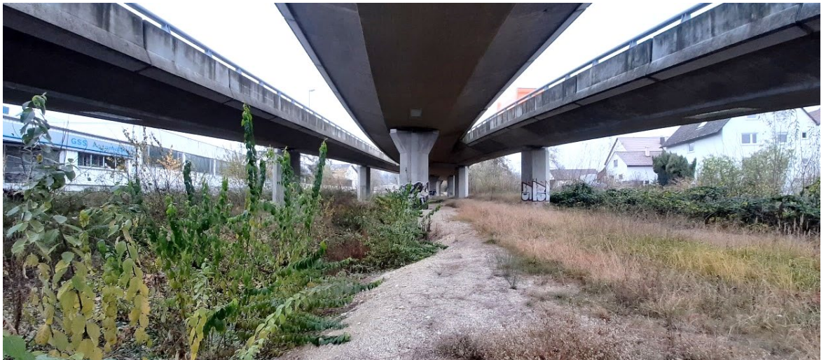
Abbildung 18 : Variante C/D, Blautalbrücke mit Blick in Richtung Süden
