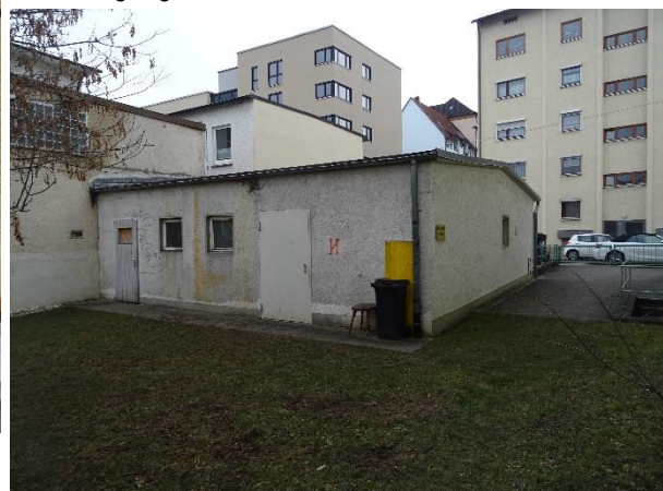
Garagen, Rückseite mit Abstellräumen, vom Hinterhof aus gesehen. Der zweite Eingang des Bunkers befindet sich innen in diesen Räumen.
