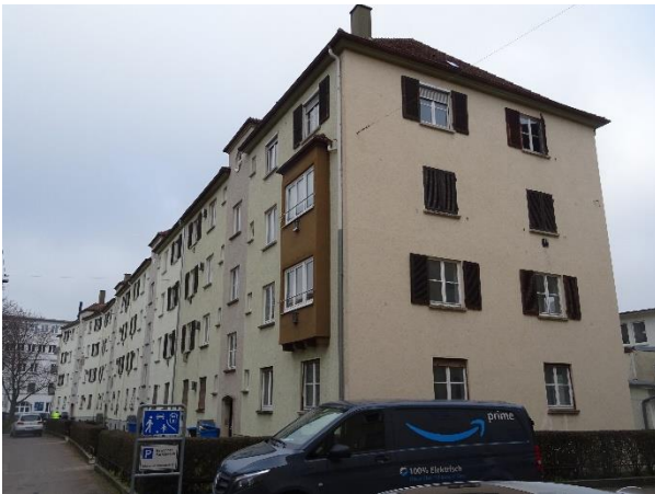
Umlandstr. 2-8, Vorderseite, Blick von Süden. Im EG Jalousien, im 1. Stock aufwärts Holz-Fensterläden.
