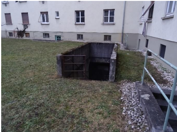
Nord-Zugang zum Bunker.
