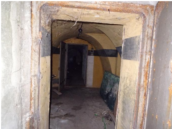
Blick durch die geöffnete Metalltür in den Bunker in Richtung Süden.
