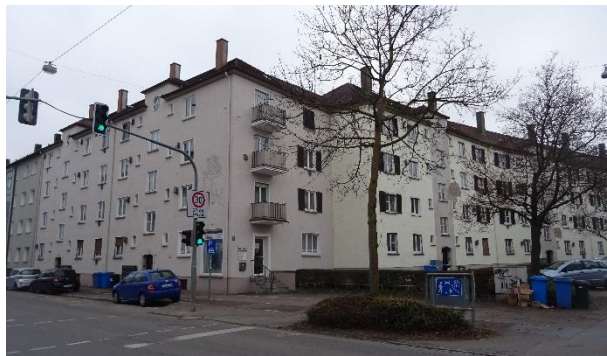
Blick von Nordwesten auf die Ecke Umlandstraße-Söflinger Straße.
