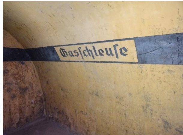
Am Südenende war die „Gasschleuse“.
