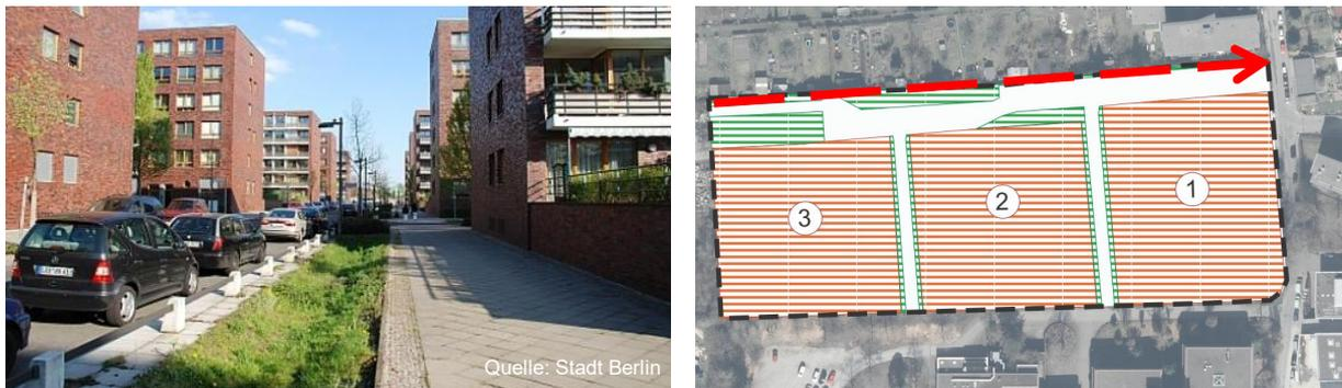
Abb. 8: Ausführungsbeispiel für ein Mulden-Rigolen-System (links) und Lage im Baugebiet (rechts)
