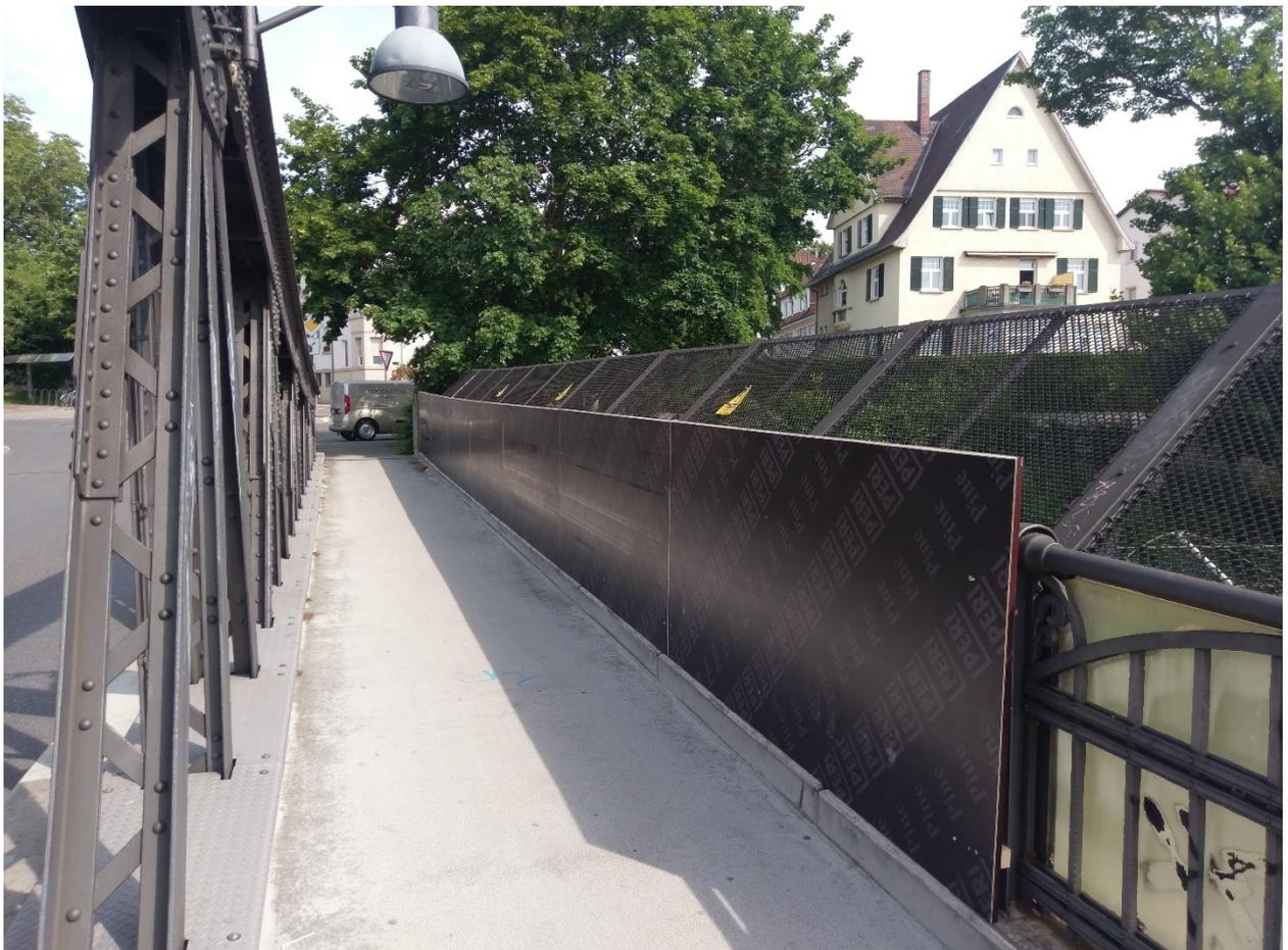
Es ist deshalb erforderlich, die bestehenden schrägen Berührschutzelemente abzubauen und durch einen den Richtzeichnungen entsprechenden vertikalen Berührschutz auszutauschen.
