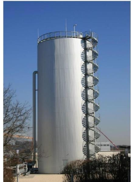
**Abbildung 14: Wärmespeicher der FUG
