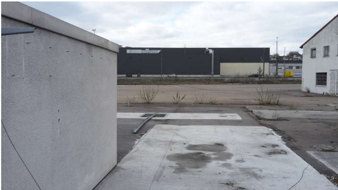
Abbildung 12: Blick aus Gebäude-Komplex - Blaubeurer Str. 70/1 in Richtung Nord auf die Fahrzeug-instandhaltungsanlage der Bahn (FIBA), Foto 6.
